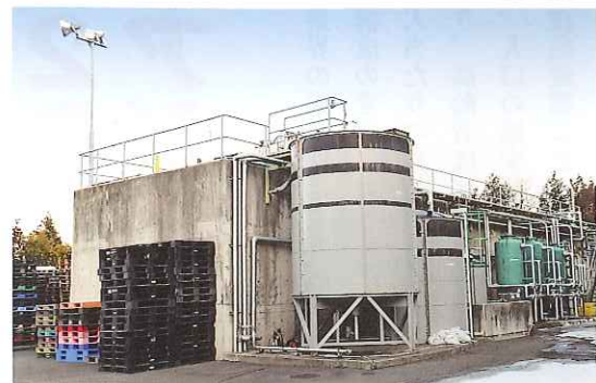
リサイクル原料の洗浄廃水は工場内の施設で処理する。その他の二次公害要因もすべて工場内に封じ込めて処理
