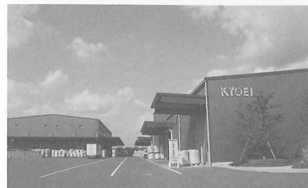
最新鋭の設備を備え月産3,000トンの生産量誇る小山工場
